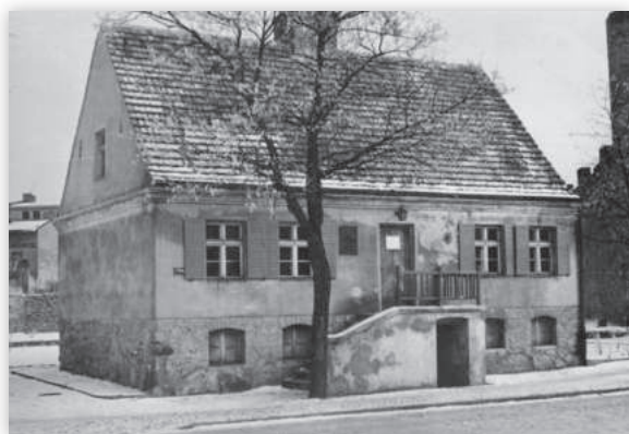
Dom Staszica – po 1955 r. (fot. R. Zaranek)
